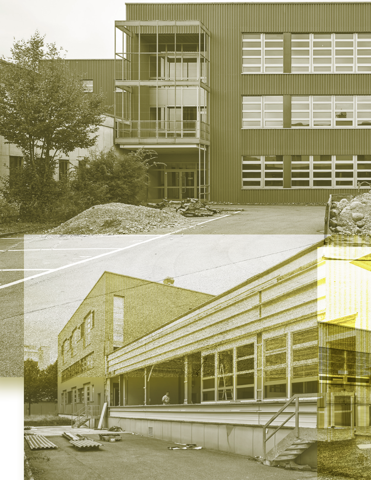
Von einem Druckereigebäude in Winterthur sind die Fassadenpaneele erhalten und für die neue Außenhülle wiederverwendet worden.
