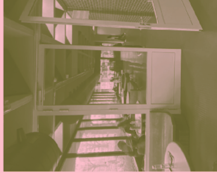
2-flügelige Brandschutztüranlage DIN R mit GEZE Türantrieb 4545x3080 mm
